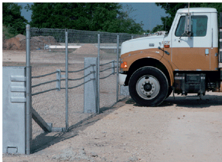
36. ábra: Jármű elleni megerősített drótkerítés
