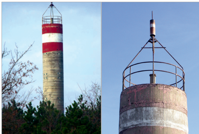
3.2. ábra: Vasbeton mérőtorony vasbeton pillér műszerállással [2]
