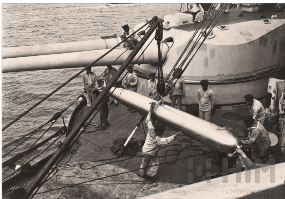
4.2. kép. Torpedó beemelése a Zrínyi csatahajó fedélzetére
