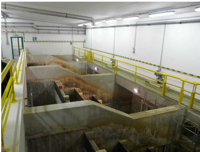
3.1. ábra: Nyitott levegőztető kaszkád és szellőző a Csepeli Vízműben (a szerző felvétele)
