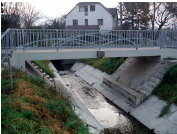
3. ábra: A Határ-árkonon kihelyezett vízszintészlelő berendezés hídra szerelt mérődoboz (FCSM Árvízvédelmi Osztály felvétele)
