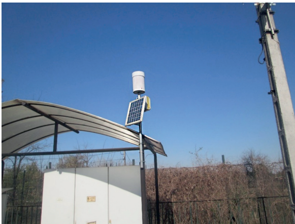
2. ábra: Egy FCSM-csapadékmérő jellemző elrendezése (Lőrinci út) (FCSM Árvízvédelmi Osztály felvétele)
