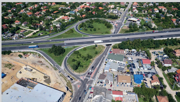
M7 Érd, Iparos úti csomópont megvalósítása – szakaszolt projekt
