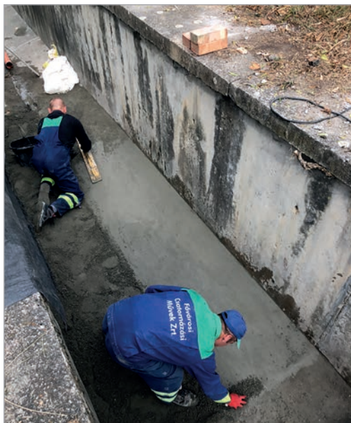
5. kép: Burkolatjavítás (Beregszászi úti árok) (a szerző felvétele)
