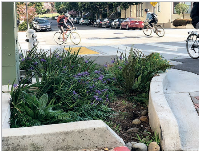
1. kép: Út melletti mini esőkert – San Francisco, USA [10] (a szerzők felvétele)
