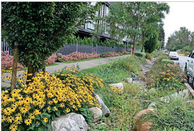
3. kép: Út melletti esőkert – Willoughby, Ausztrália [12] (a szerzők felvétele)
