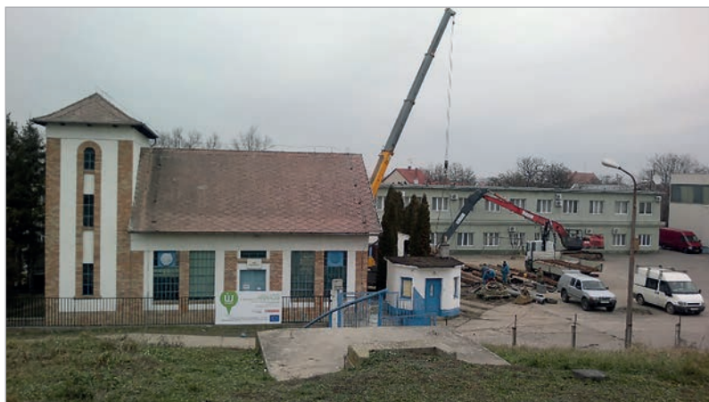
9. ábra: Tápéi szivattyútelep rekonstrukciója (a szerző felvétele)
