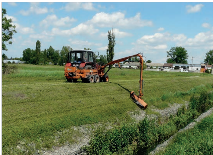
2. kép: Kisvízfolyás kaszálása traktorral (Gyáli-patak VII. ág) (a szerző felvétele)
