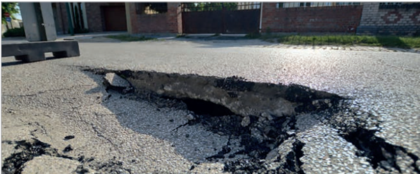
1. kép: Az Eötvös utca útburkolatának megsüllyedt pontja (Kiskunhalas) [16] (a szerző felvétele)
