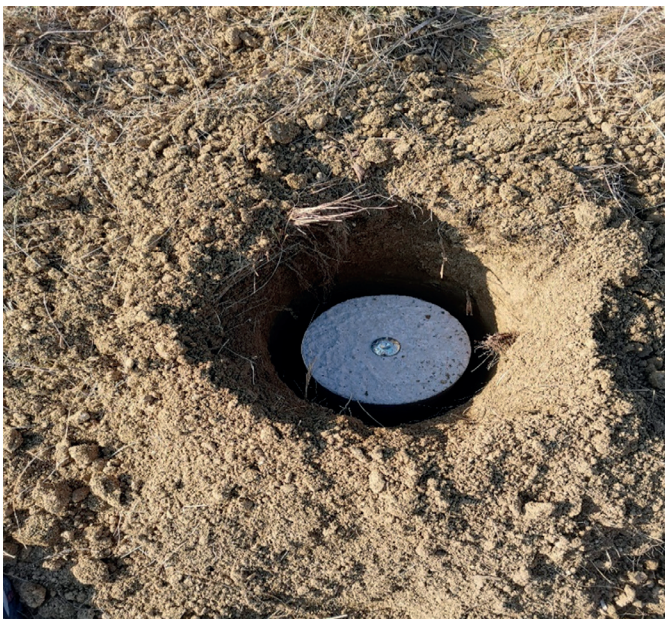
7. ábra: A geodéziai mérőpont beépítés közben
