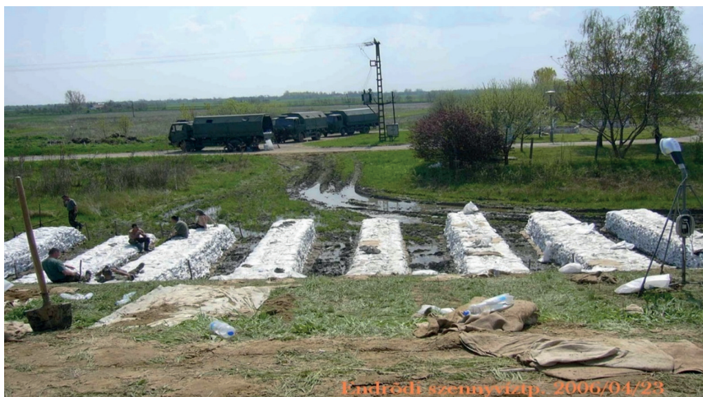
1. ábra: Az endrődi szennyvíztelepnél bordás megtámasztással való védekezés, 2006
