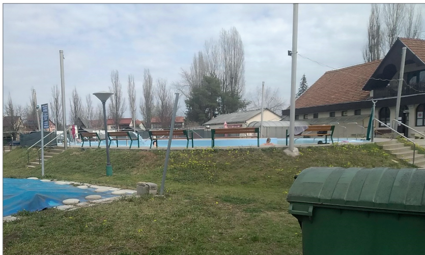
7. ábra: Elmaradt fürdőfelújítás
