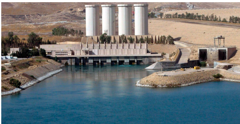
5. ábra: A moszuli vízerőmű
