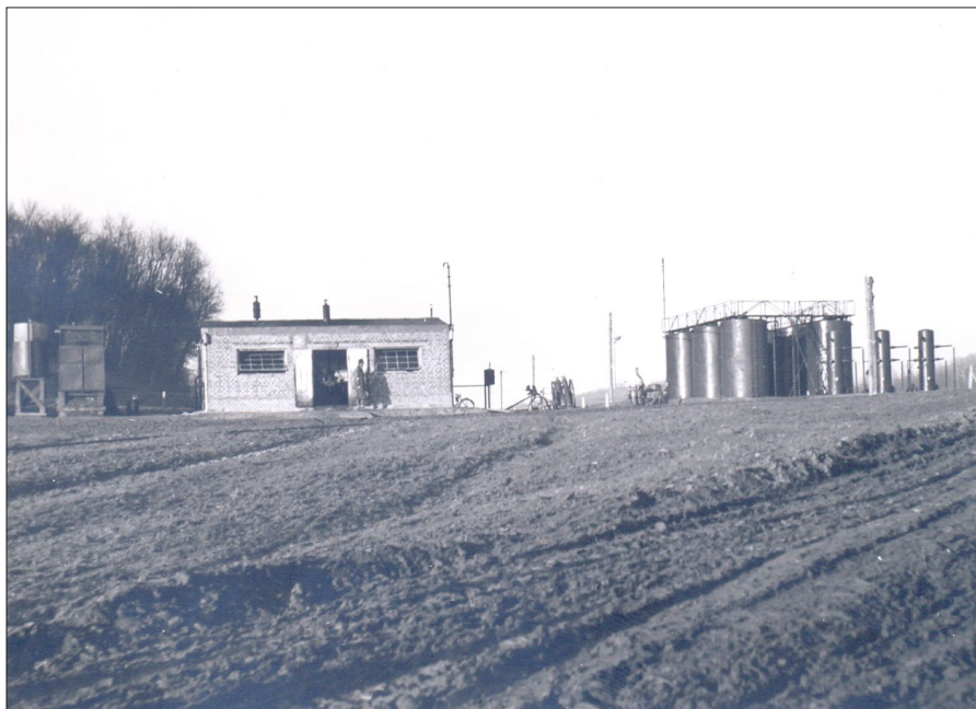
12. kép. A B-2-es fúrás közelében lévő tankállomás
